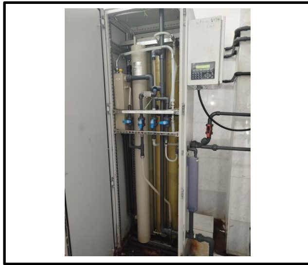
Figure 11 : Système d'osmose inverse de la salle Gambro (Photo prise par Mallem et Aouaichia ).
