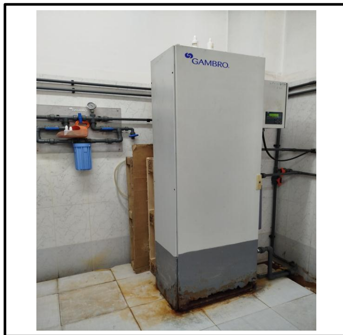
Figure 10: un placard métallique fermé contient le système d'osmose (Photo prise par Mallem et Aouaichia).
