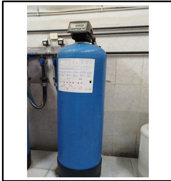
Figure 8 : Filtre à charbon actif ( Photo prise par Mallem et Aouaichia )
