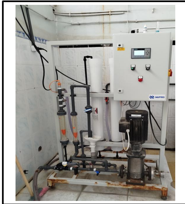
Figure 14 : système d'osmose inverse de la salle Nipro ( Photo prise par Mallem et Aouaichia )
