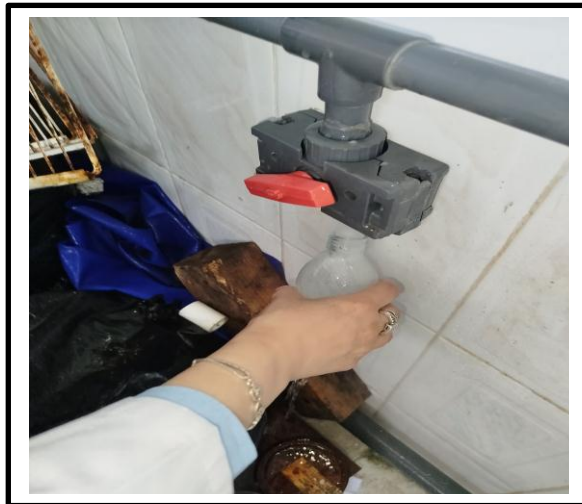
Figure 20 : Prélèvement d'eau au point de sortie après l'osmoseur (eau osmosée) de système Nipro ( Photo prise par Mallem et Aouaichia )
