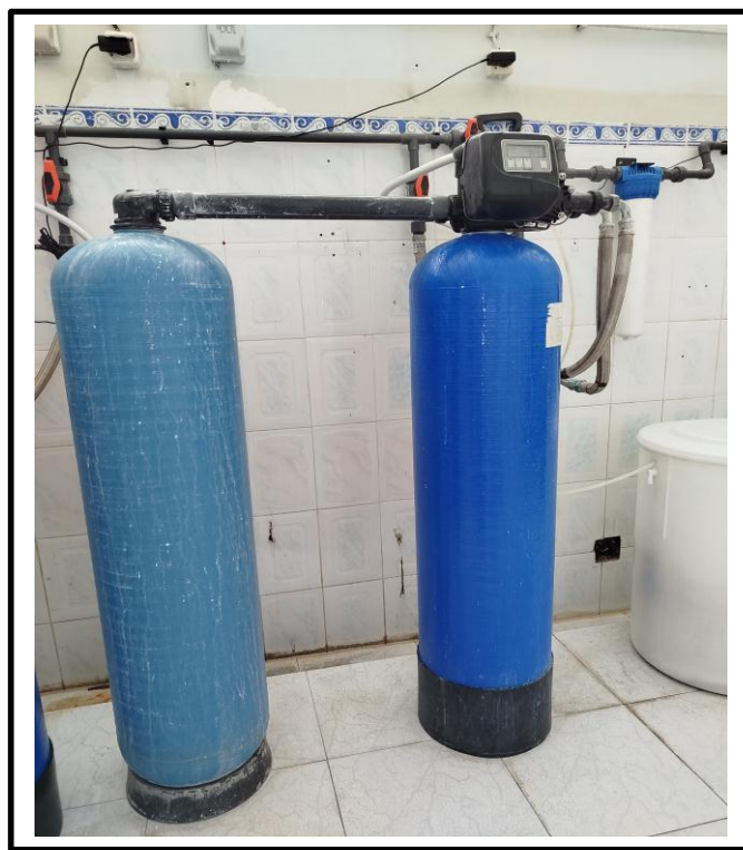
Figure 13 : Adoucisseur duplex avec têtes de contrôle Clack TT ( Photo prise par Mallem et Aouaichia )
