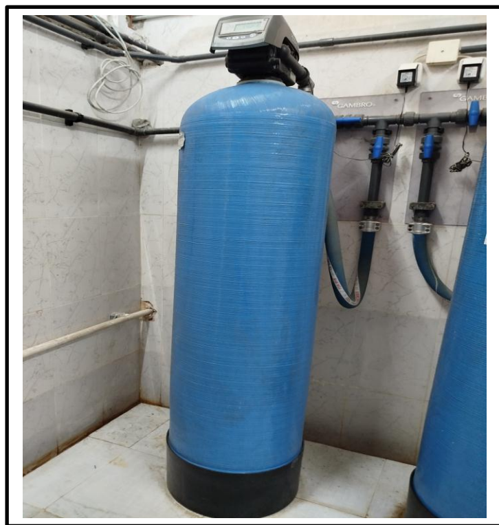
Figure 7 : Filtre à sable (Photo prise par Mallem et Aouaichia)
