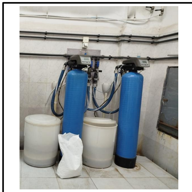
Figure 9 : Adoucisseurs (Photo prise par Mallem et Aouaichia).
